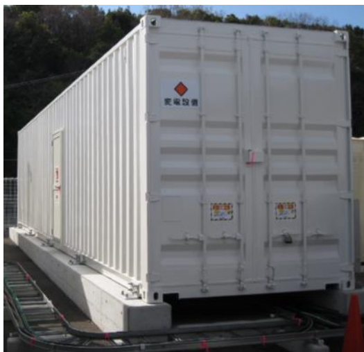
受配電設備 (40ftコンテナ内収容)
