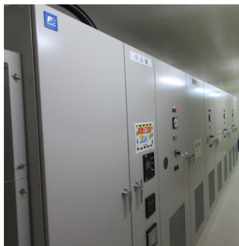
受配電設備 (40ftコンテナ内収容)
