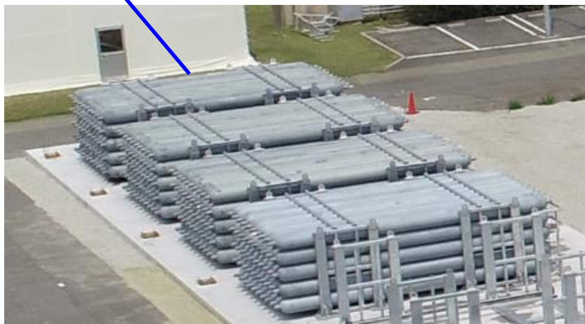
全7基中、4基を据付時点の写真
