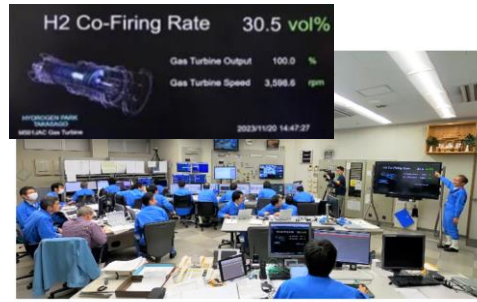
2023年11月20日14時47分 水素30%混焼到達 (写真：中央制御室)
