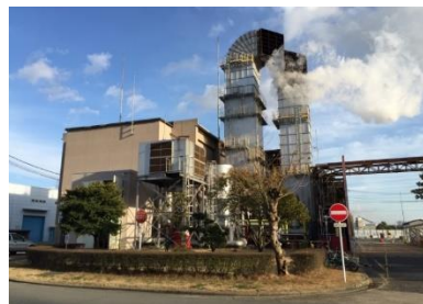
実圧燃焼試験設備
