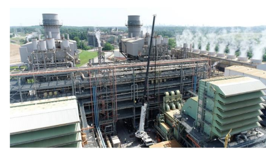
マクドノフ・アトキンソン発電所 (写真提供：ジョージア・パワー)
