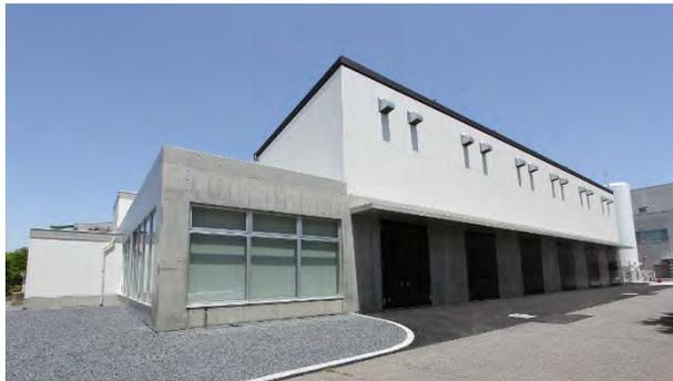
**防爆実験室** : W6m x D7m x H10m, 耐床2ton/m<sup>2</sup>、軽量屋根、破裂用窓、障壁30cmx6m、安全策 (水素検知器、監視カメラ、排気設備)
