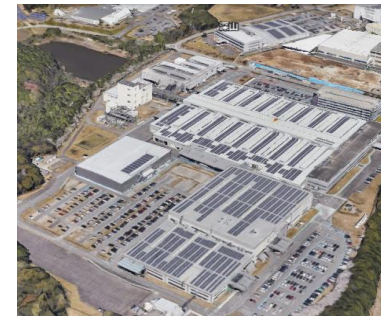
2.5MWの太陽光発電
